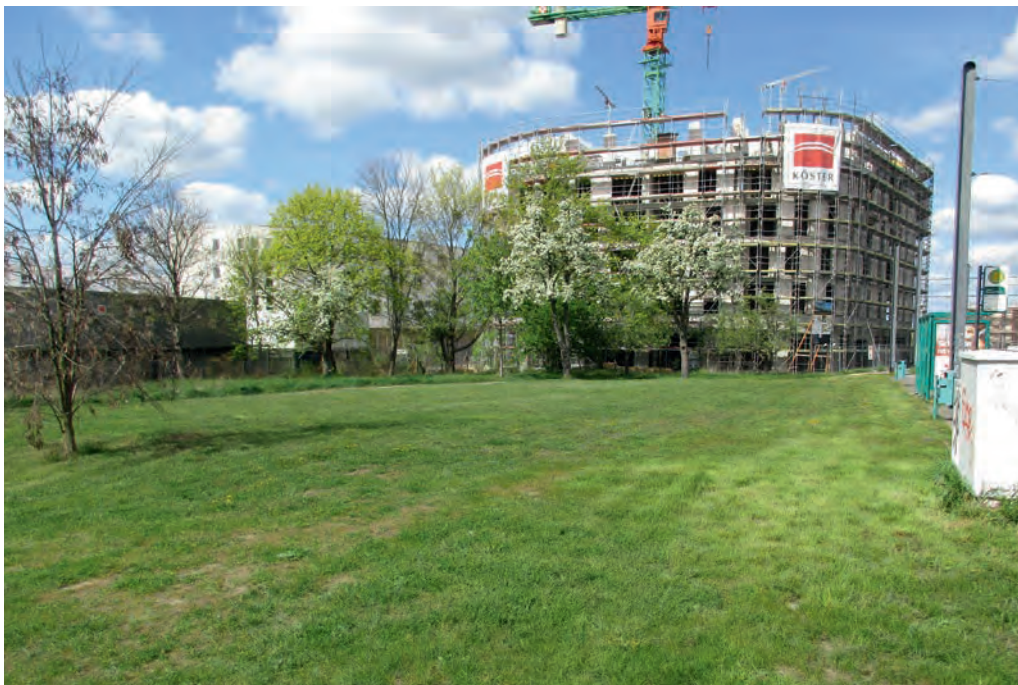
Die Stadt muss neue Wohnungen bauen, damit die Mieten nicht weiter steigen. Doch auch die Nebenkosten durch Versorgungsleistungen müssen erschwinglich sein.
